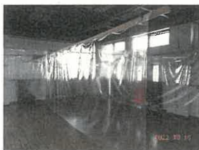
図-47：ビニールシートでの区画
