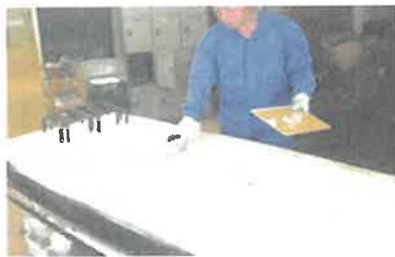
◆炉内台車耐火材の簡易修繕
