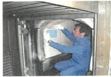
◆炉内耐火材部分修繕
