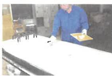
◆炉内台車耐火材の簡易修繕
