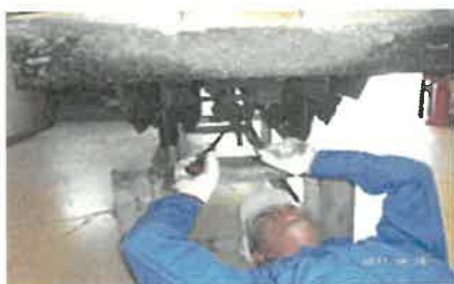
◆炉内台車車軸交換
