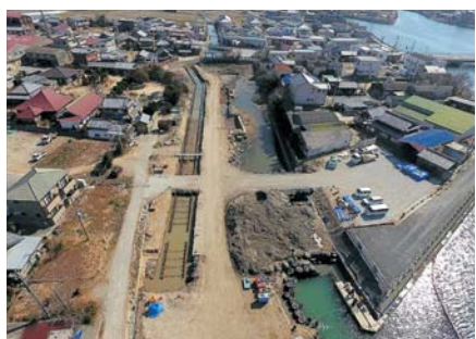
▲堀岸川護岸整備工事
