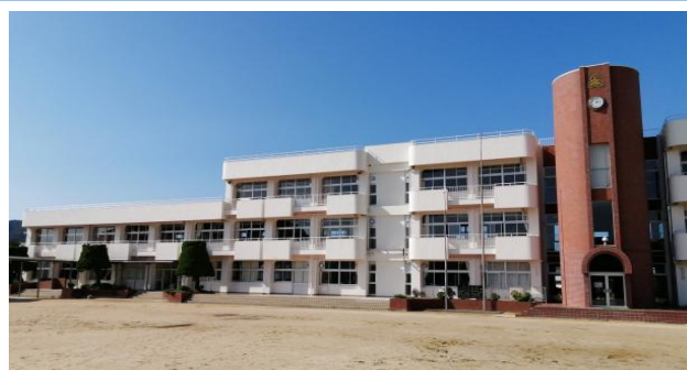
賀集小学校 大規模改造工事
