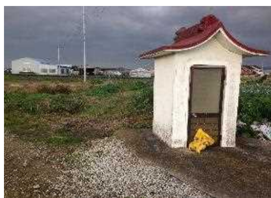
がくがはらの外観
