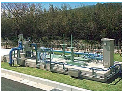
▲賀集浄化センター
