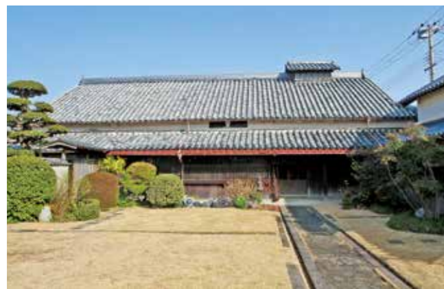
景観形成重要建造物に指定された榎賀家住宅
