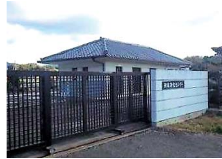
▲下水放流施設
