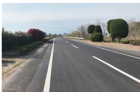
▲修繕された道路
