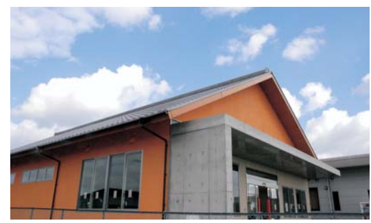
▲兵庫県農業共済組合南あわじ市事務所(建設中)
