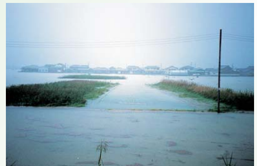
▲平成16年 台風23号により浸水した道路
