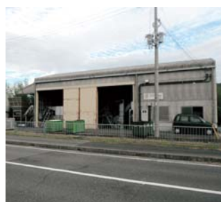
▲バイオマス利活用施設(北阿万センター)
