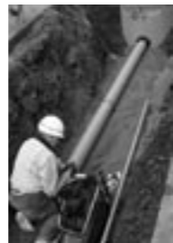
▲下水道管敷設工事
