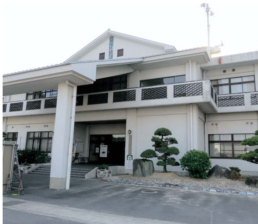
▲改修工事を行う湊地区公民館（6ページ参照）
