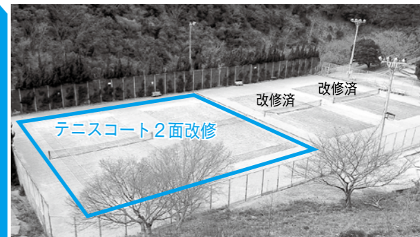
▲左2面が3月7日に改修予定。右2面は改修済みです
