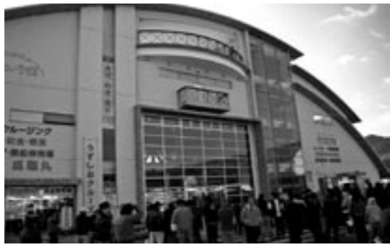
▲なないろ館建物中央の吹き抜け部分にガラスの壁を新設
