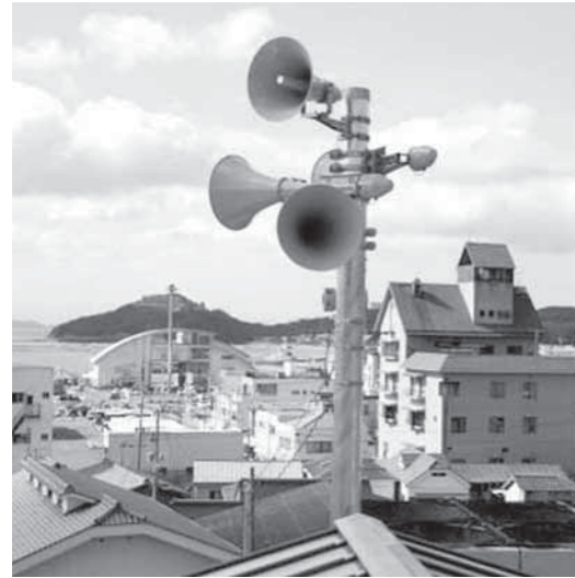
▲防災行政無線により、住民へ各種の通報が迅速・正確にできる
