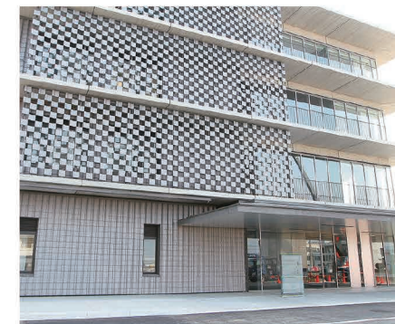
外壁や渡廊下のひさしなど積極的かつ効果的に瓦を利活用
