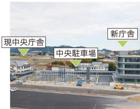
主要建物が中央駐車場に面した配棟
