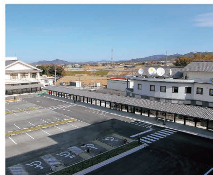
新庁舎と既存庁舎をつなぐ渡廊下
