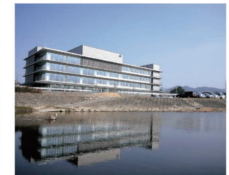
周辺の豊かな自然との調和をめざし、市民の皆さまが自然を感じられる居心地の良い庁舎
