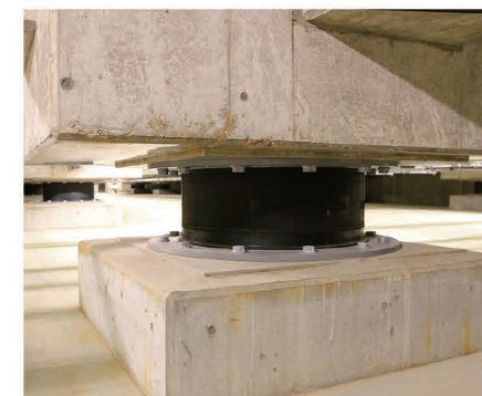
免震構造の採用による震災直後からの拠点機能を維持
