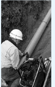
▲下水道管布設工事
