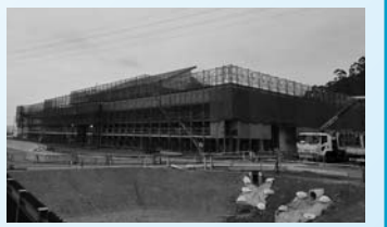
▲建設中の食の拠点施設(1月下旬撮影)
