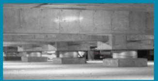
▲建物の各柱下部に設置された免震装置
