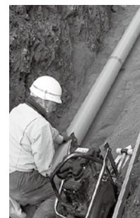
▲下水道管布設工事
