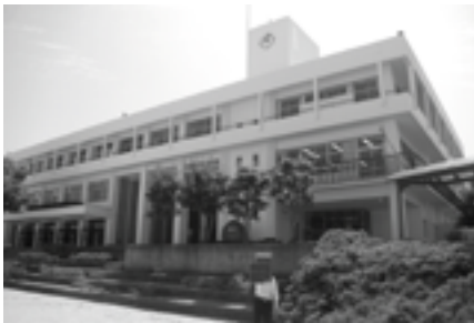
▲南淡中学校校舎大規模改造工事
