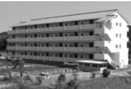
▲しづおり第2団地建設工事
