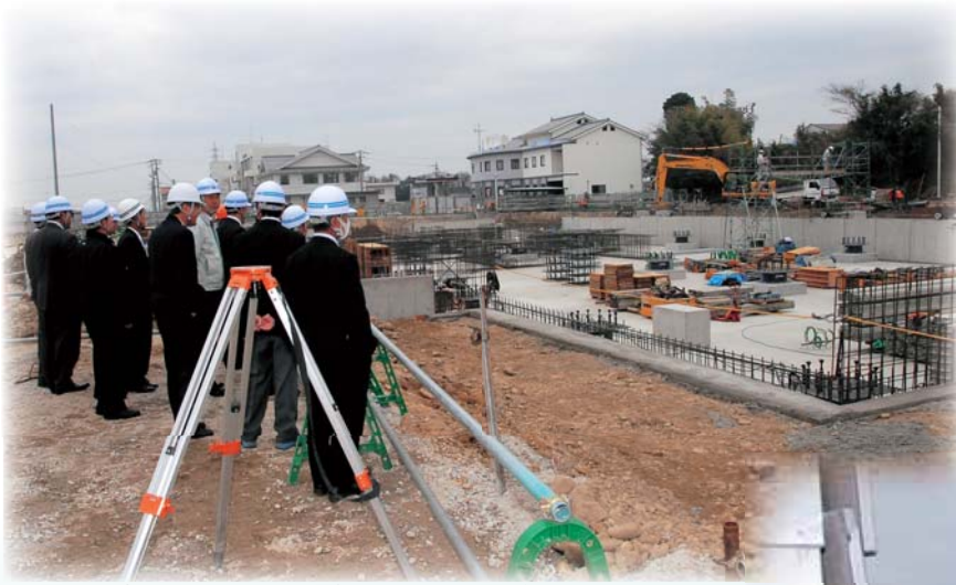
▲地震の揺れを吸収する免震装置を見学
