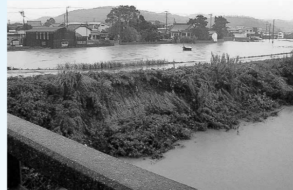
▲大雨・台風時の倭文川右岸外側冠水状況
