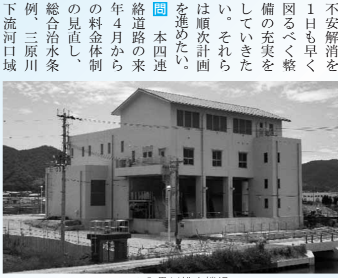
▲入貫川排水機場
