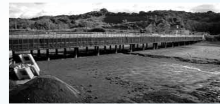
▲建設が進む茶屋池線 国道とオニオンロードを結ぶ
