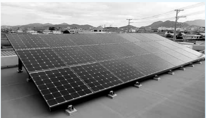
▲太陽光パネル
