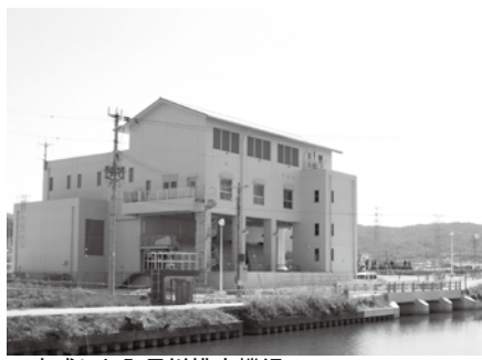
▲完成した入貫川排水機場
