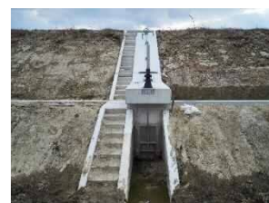
取水施設(底樋)
