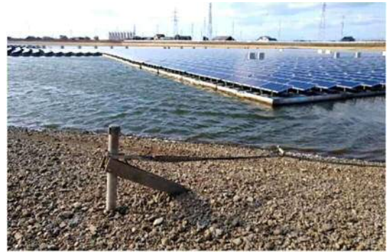
打ち込みアンカーによる係留
