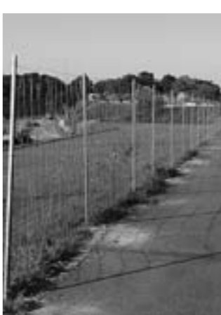
▲設置した野生動物防護柵
