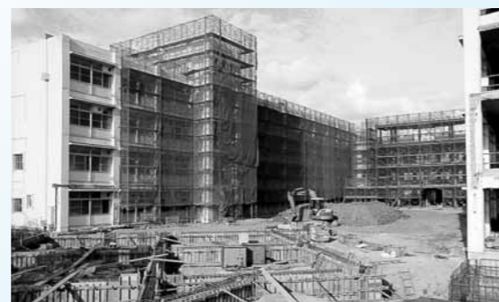
▲25年春開学に向けて耐震・改修工事を進めている吉備国際大学志知キャンパス
