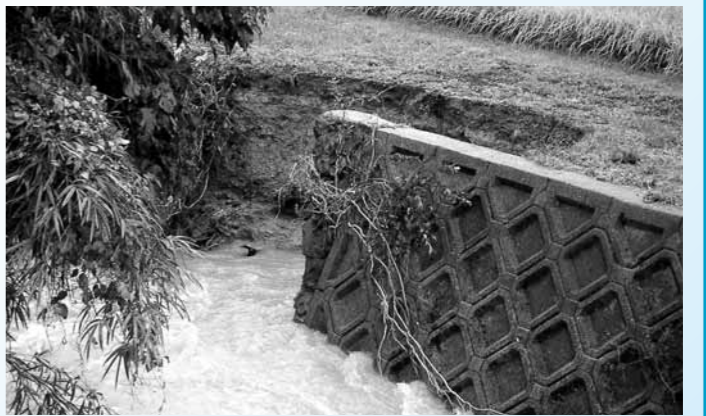
▲集中豪雨による被害を受けた除川（広田）
