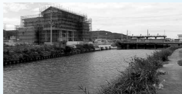
▲25年6月頃供用開始を目指し工事の入貫川排水機場(松帆)
