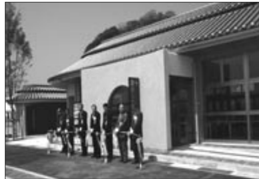
南淡町 灘ターミナルセンターを建設
