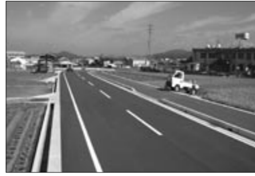
三原町 市道国分善光寺線を建設
