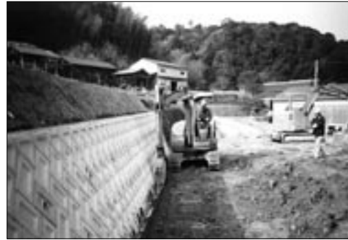
南あわじ市 台風被害の復旧工事
