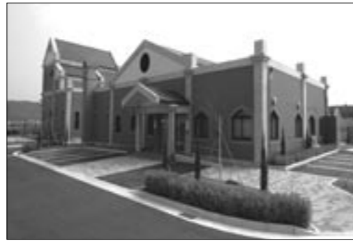
緑町 広田浄化センターを建設
