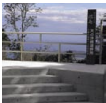
▲完成した展望台「天の浮橋遷拝所」
