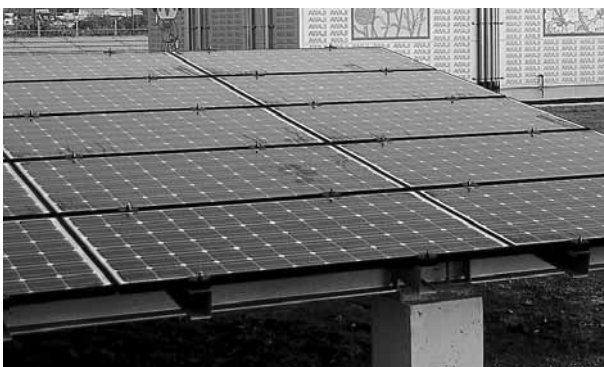
太陽光パネル
