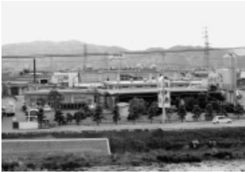
老朽化の進む牛乳工場
