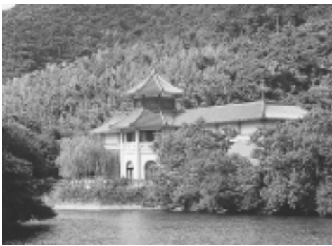
南面の殿堂 玉青館
