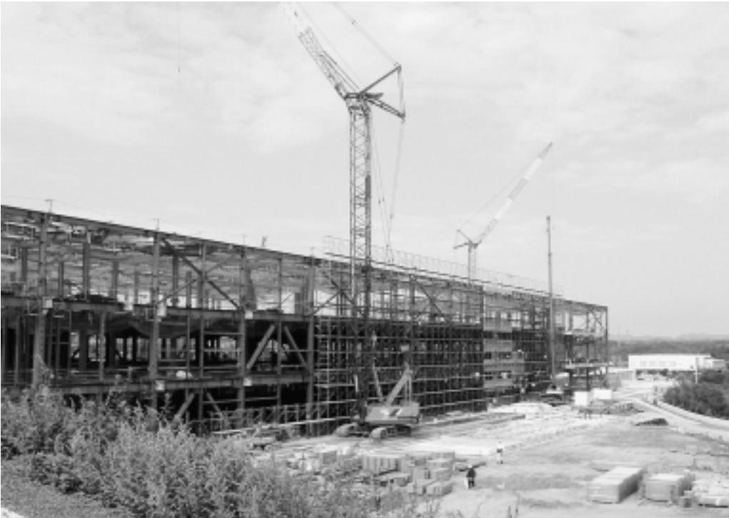
企業団地で急ピッチに進む工場建設
