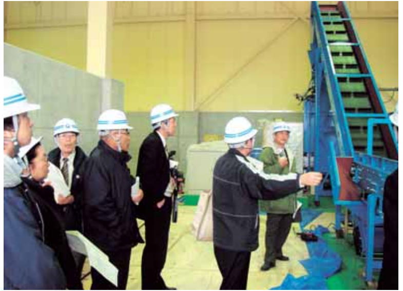
▲リサイクルセンター内部
