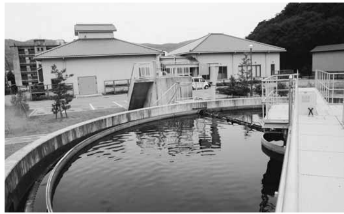
▲下水道処理施設（福良浄化センター）
