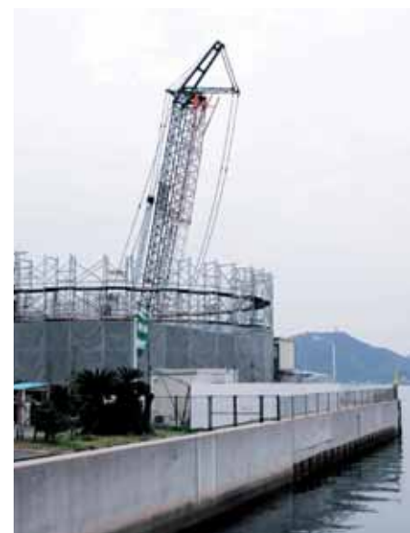
▲建設が進む福良港津波防災ステーション(福良湾)
