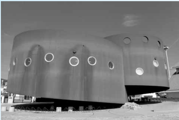
▲9月にオープンした「福良湾津波防災ステーション」
