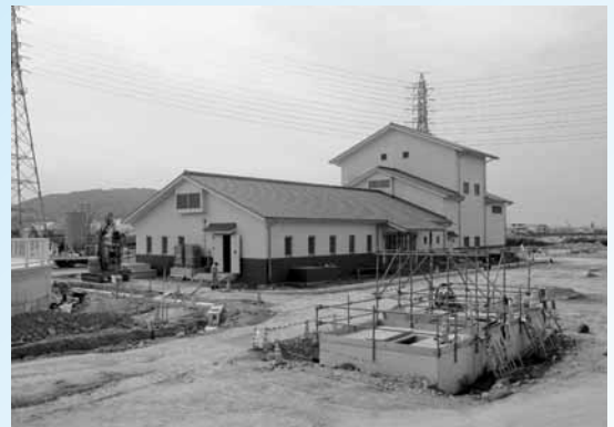
▲建設中の松帆・湊浄化センター (平成23年3月31日一部供用開始予定)
