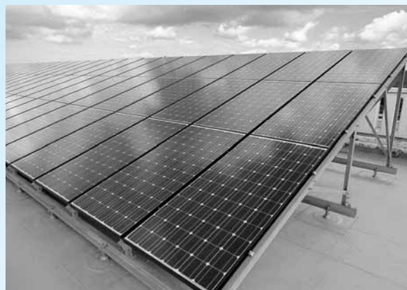
▲校舎に設置された太陽光パネル(八木小学校)
