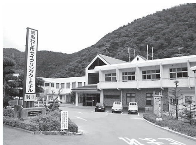
▲スポーツ施設や温泉、宴会場などを完備した宿泊施設サンライズ淡路(上)とサイクリングターミナル(下)
