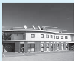
▲ケーブルネットワーク 淡路局舎
