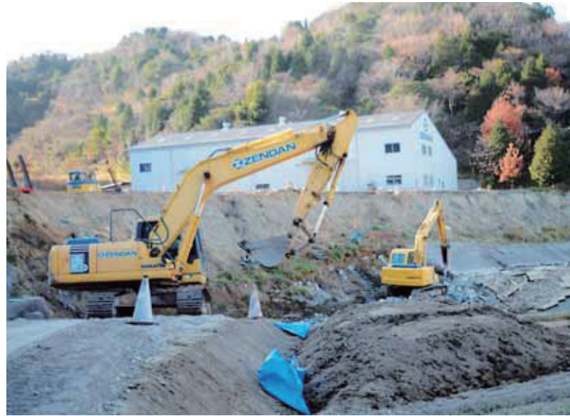
▲台風被害を受けた農地農業用施設の復旧工事(広田)
