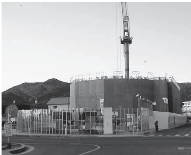
▲建設中の「淡路人形会館(仮称)」。完成後は「淡路人形浄瑠璃館」に
