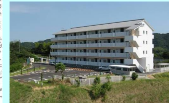
公営住宅等整備事業(しづおり第2団地) 地域創造支援事業 公営高齢者向け設備整備事業
