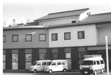
大きなパラボラアンテナが目印 ケーブルネットワーク淡路
