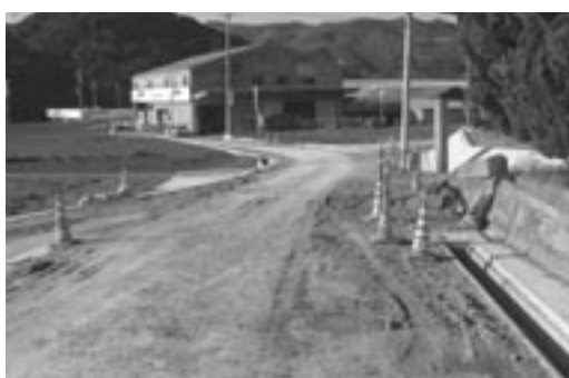
▲拡幅工事中の町道広田南線
