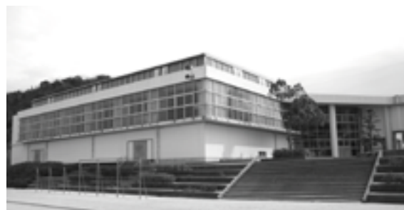
◀ 大規模改修する南淡中学校 体育館
