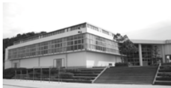
◀ 大規模改修する南淡中学校 体育館
