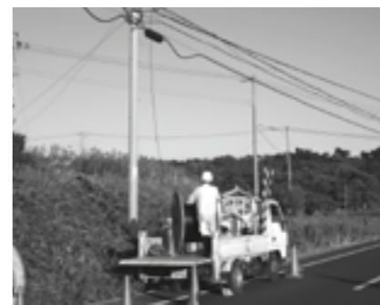
▲ケーブル張替・張増工事
