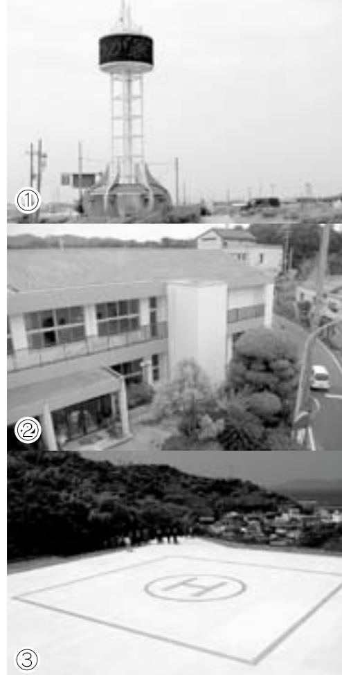
▲①オニオンタワー建設工事 ②倭文小学校耐震補強・大規模改造工事③沼島地区ヘリポート設置工事
