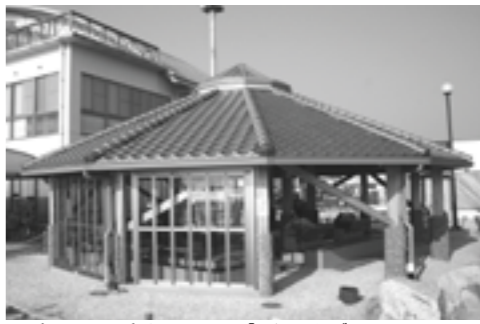
▲防風扉と天窓を設置した「足湯・うずのゆ」
