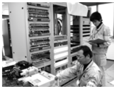
▲地上デジタル放送用センター機器の整備
