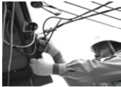
▲引込工事(保安器の取り付け)
