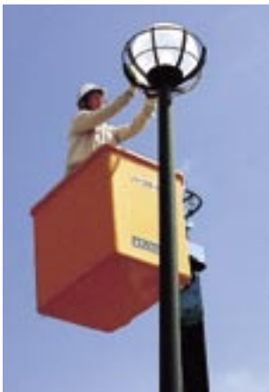
▶高所作業車を使って電球の点検と清掃（陸の港西淡）
