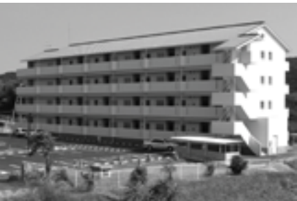
▲しづおり第2団地建設工事
