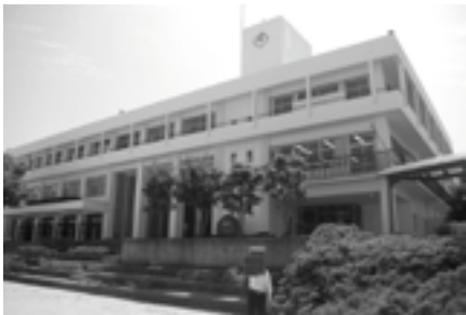
▲南淡中学校校舎大規模改造工事
