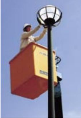
▶高所作業車を使って電球の点検と清掃(陸の港西淡)
