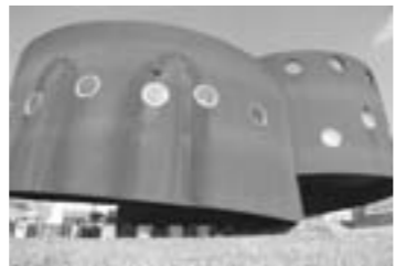
▲福良港津波防災ステーション
