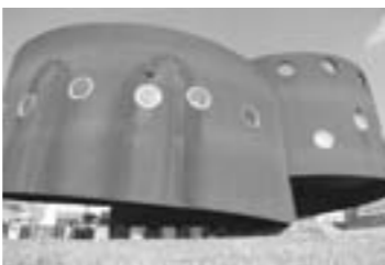
▲福良港津波防災ステーション
